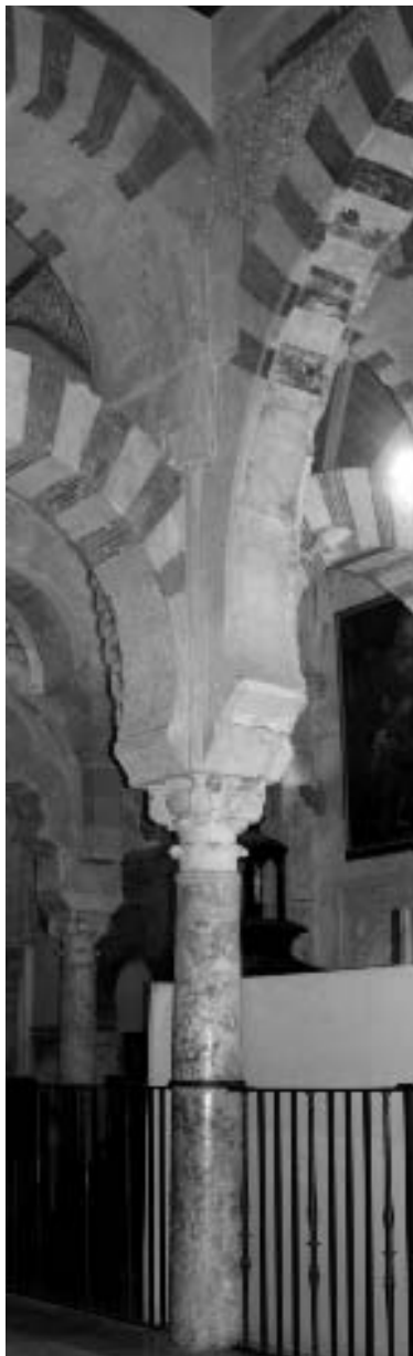
Figura 8. Arquerías entrecruzadas sobre una columna de la mezquita de al-Ḥakam II
