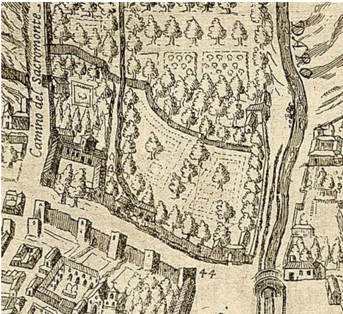
Fig. 6. Plataforma de Granada de Ambrosio de Vico. Casa del Chapiz.
